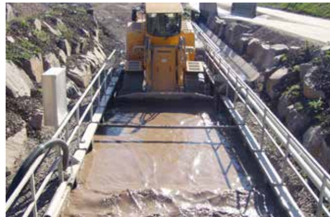
Évacuation manuelle des boues à l'aide d'une chargeuse sur roues Asportazione manuale dello sporco tramite caricatore su ruote
