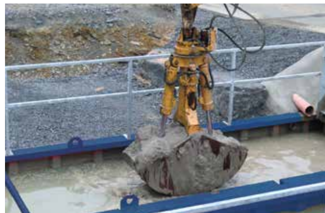
Évacuation manuelle des boues à l'aide d'une pelleuse Asportazione manuale della sporcizia tramite escavatrice
