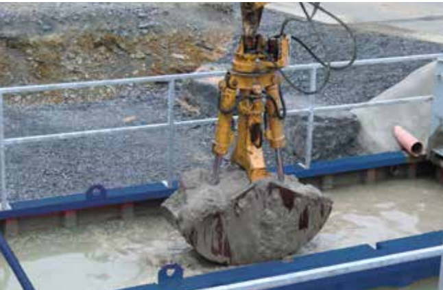
Manual dirt removal with excavator Vaciado manual de la suciedad mediante grúa
