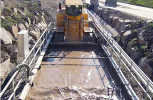
Manual dirt removal with wheel loader Vaciado manual de la suciedad manual mediante pala cargadora
