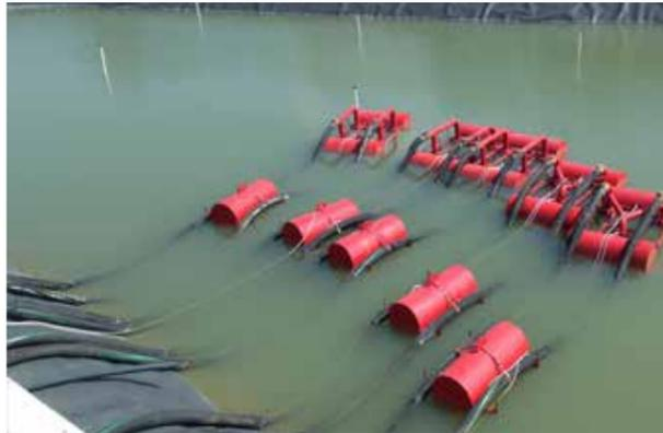
Becken mit MobyDick Pumpen und Pontons
