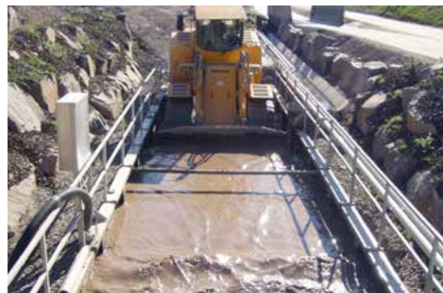
Manuální vynášení nečistot pomocí kolového nakladače Ręczny wysyp zanieczyszczeń przez ładowarkę kołową
