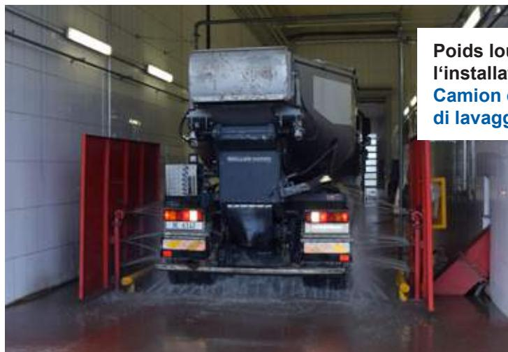
**Poids lourds et SUV: Nettoyage préliminaire avant l'installation de lavage**
