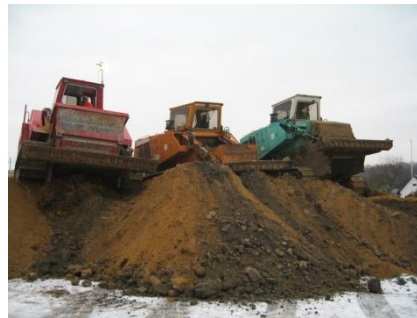
Abgetragenes Material wird auf der 200 m entfernten Deponie zwischengelagert.
